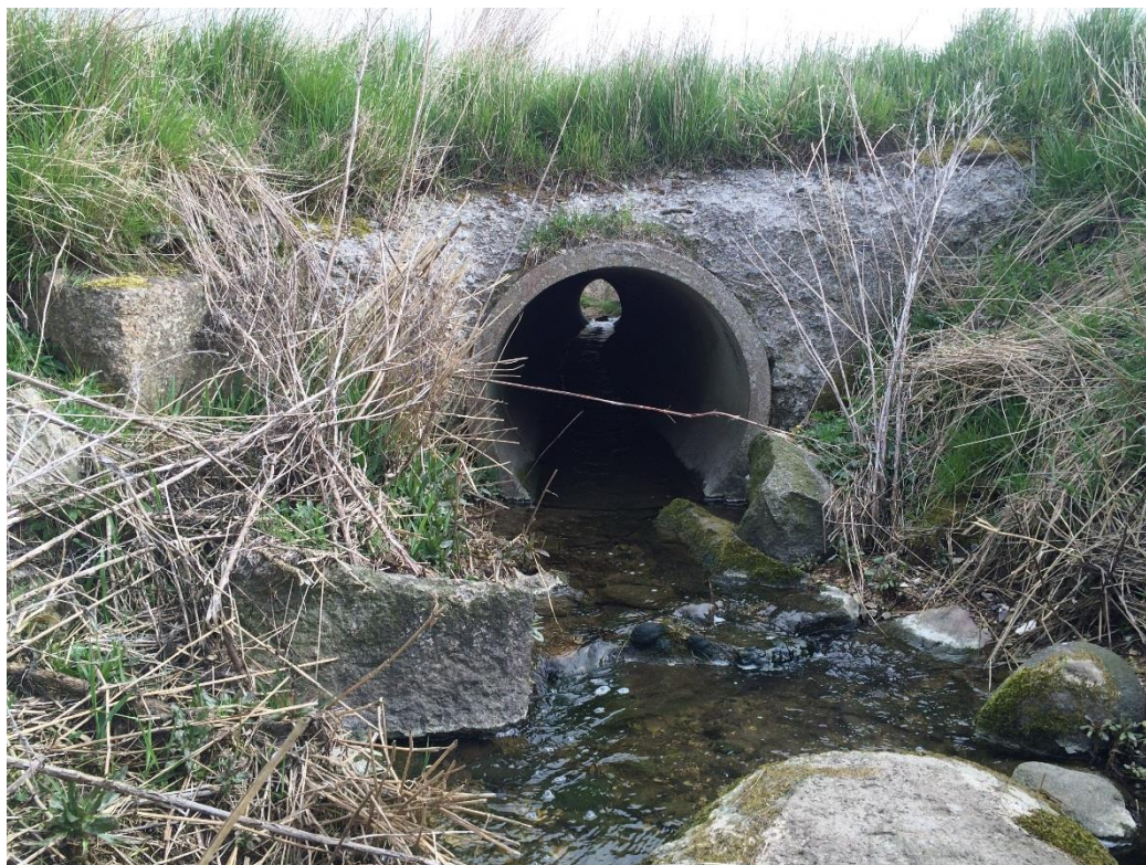
Figur 2.4 Udløb fra rørlagt strækning.
