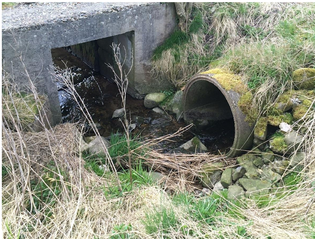
Figur 1.3 Indløb til rørlagt strækning – umiddelbart efter betonbro.
